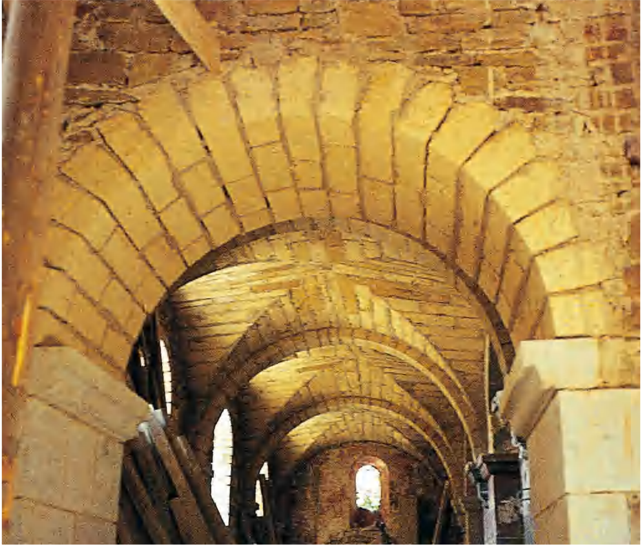
Tuffstein-Gewölbe gemauert mit Trasskalkmörtel
